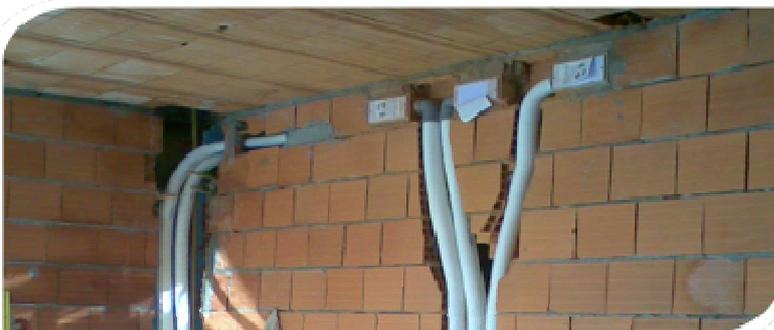
Montanti delle tubazioni nelle tracce a muro e bocchette a parete
