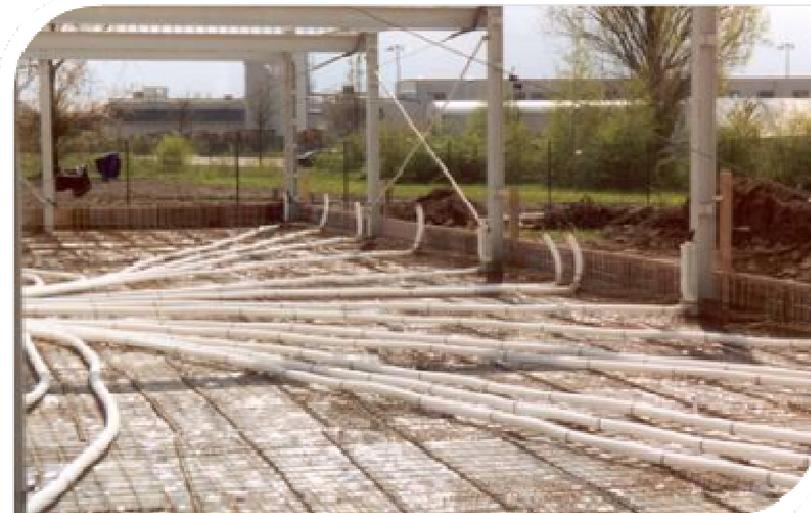
Stesura delle tubazioni su un solaio gettato in opera: maggiore spazio per il passaggio degli impianti.
