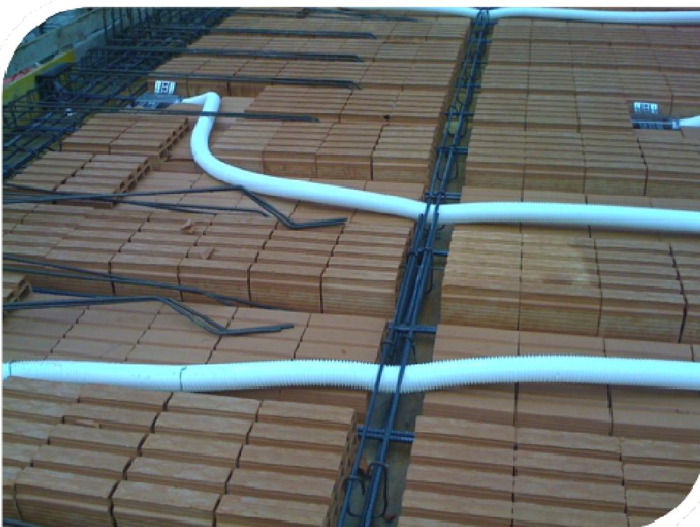
Solaio in latero-cemento con pignatte ribassate: passaggio delle tubazioni nella parte strutturale del solaio e bocchette tutte a soffitto
